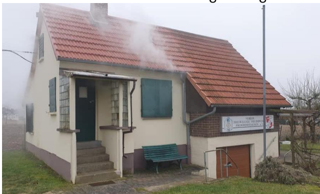
Brand in Gebäude
