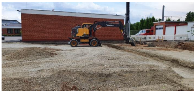
Baustelle am 19. Mai 2022
