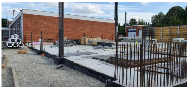
Baustelle am 14. Juli 2022
