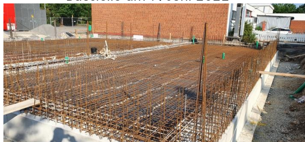
Baustelle am 30. Juni 2022
