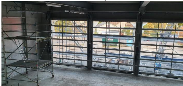
Baustelle am 8. November 2022
