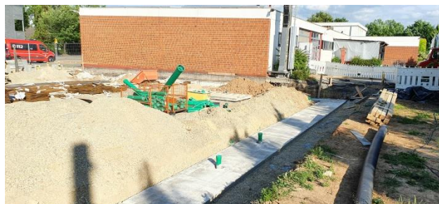
Baustelle am 9. Juni 2022
