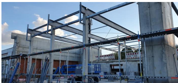
Baustelle am 22. September 2022
