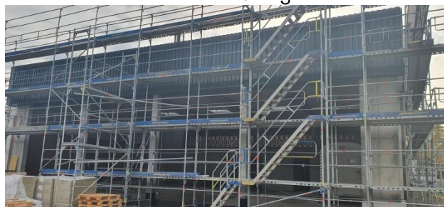
Baustelle am 30. Oktober 2022
