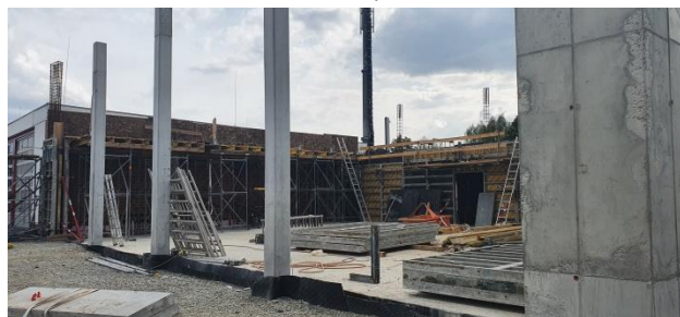
Baustelle am 19. August 2022
